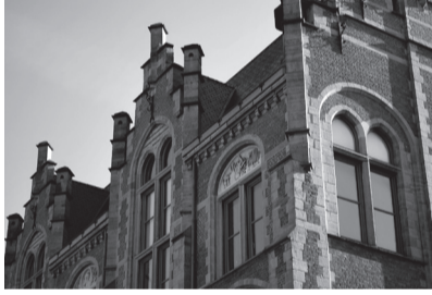
5. Rommelaere complex Intersection Hospitaalstraat and Jozef Kluykensstraat
